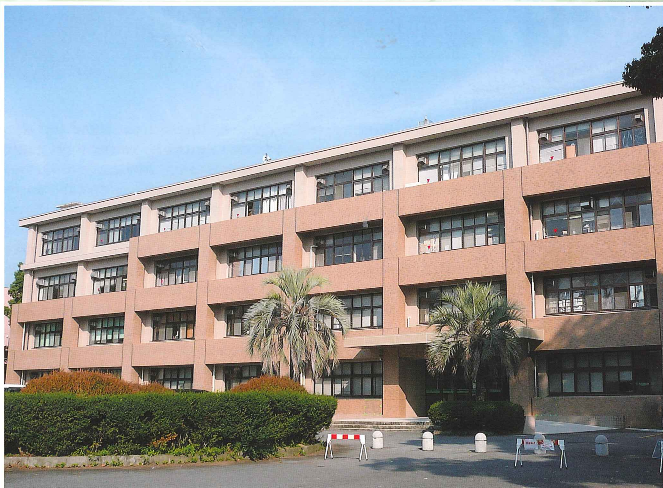
耐震工事を終え、装い新たとなった薬学部A棟正面（平成20年10月撮影）
